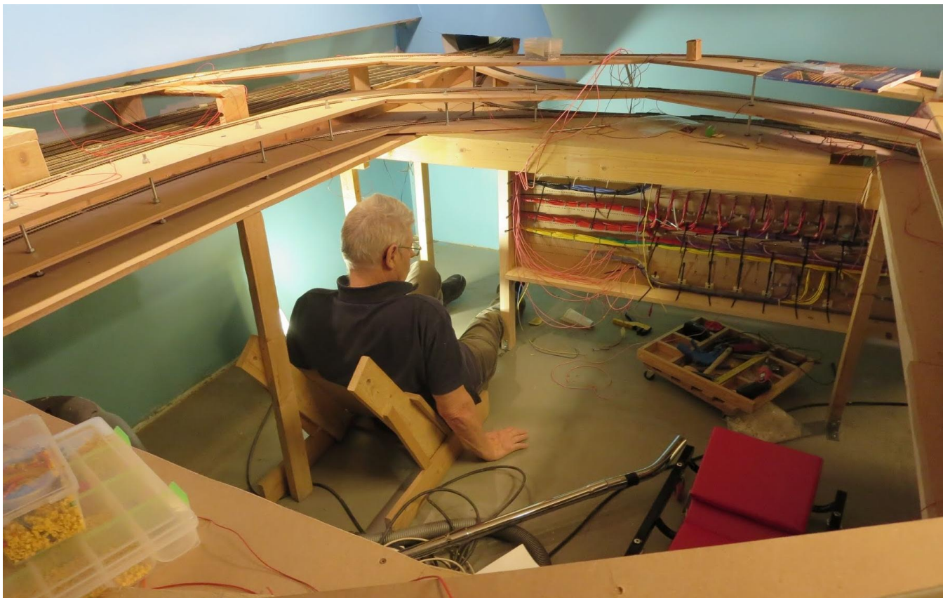
Så er den store el tavle på plads under bordet i rum 4, Bent ser helt træt ud - der er også masser af ledninger der skal monteres endnu!
