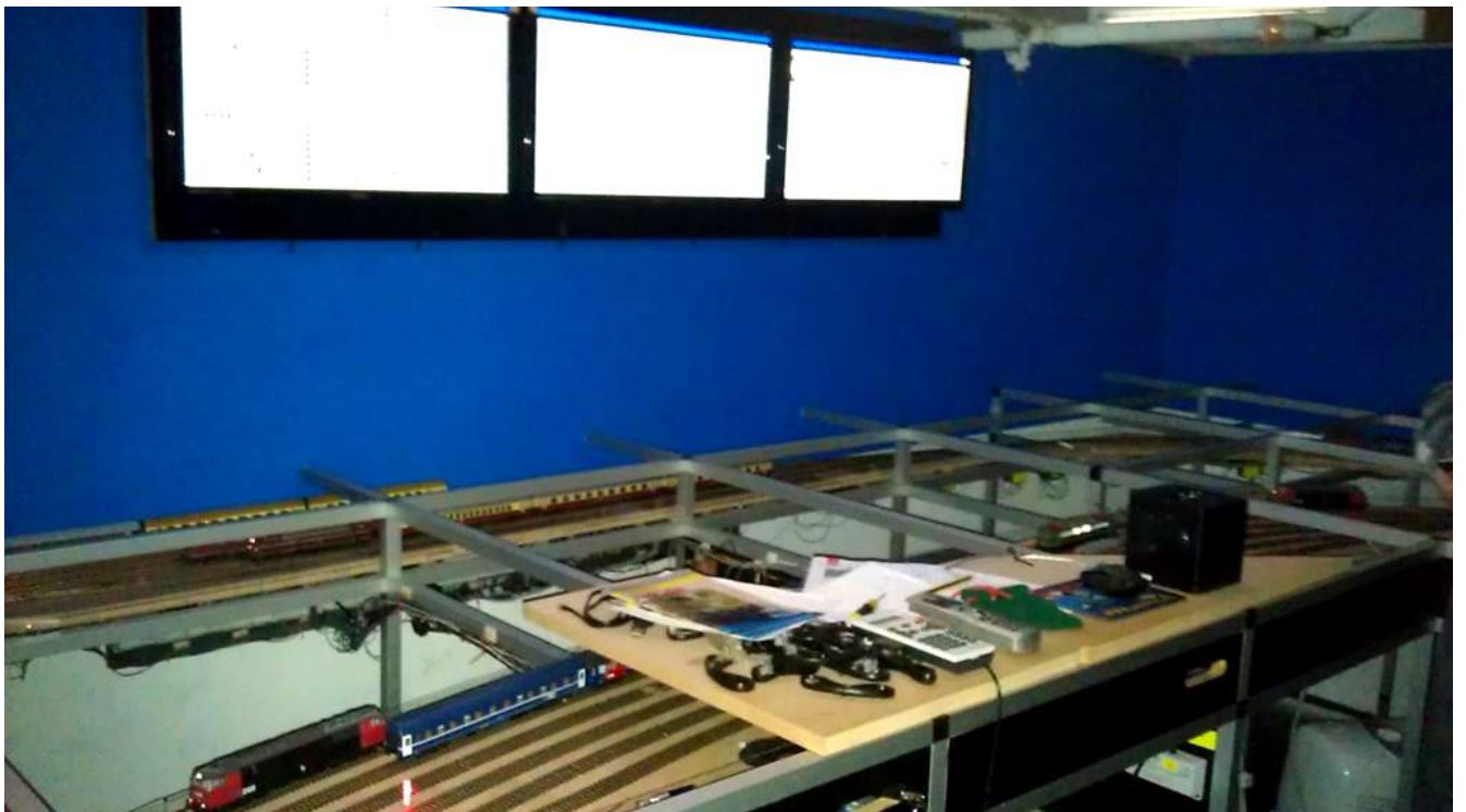
De tre fladskærme til overvågning af anlægget, der her er blevet bygget op i noget vandfast stålprofil.
